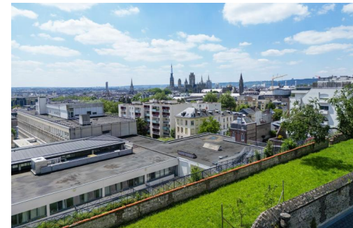
Vues panoramiques du niveau ( photos non contractuelles)
